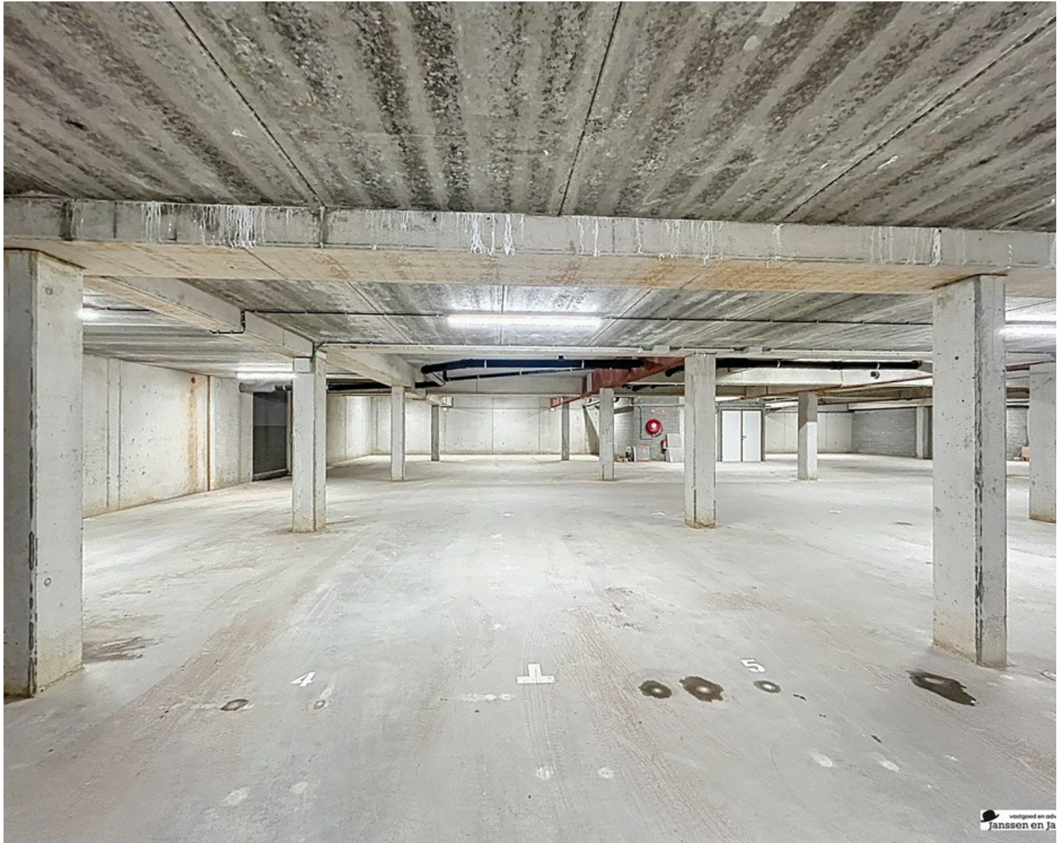
Ondergrondse autostaanplaatsen in project Goorbos
